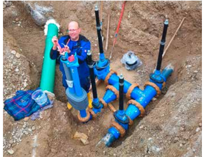
Foto: Matthias Schürle vom Zweckverband zur Wasserversorgung der Schonstetter Gruppe installiert einen neuen Unterflurhydranten.
