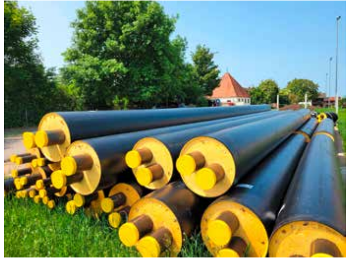
Foto: Die Rohre für den nächsten Bauabschnitt der neuen Nahwärmeleitungen in Eiselfing liegen schon bereit.
