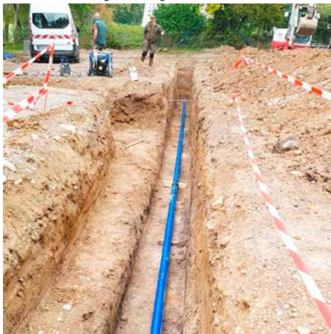
Leitungsbau durch den Zweckverband zur Wasserversorgung der Schonstetter Gruppe.
