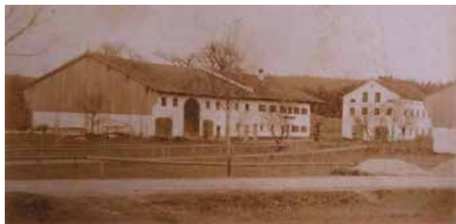
Der Saliterer-Hof vor dem Brand; das hohe Nebengebäude (= das eigentliche Saliter-Sudhaus) steht in veränderter Form heute noch. Aufnahme von 1926.
