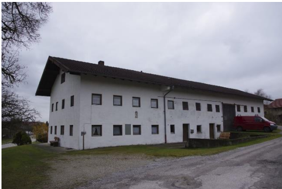
Abb. 10 Abzubrechendes Wohngebäude auf FINr. 197, Blickrichtung Süd, Foto: LaN, 22.11.23
