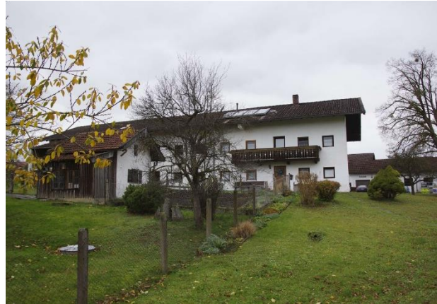
Abb. 7 Abzubrechendes Wohn- und Nebengebäude auf FINr. 197, Blickrichtung Nord, Foto: LaN, 22.11.23
