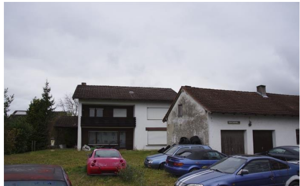
Abb. 11 Abzubrechendes Wohngebäude mit Nebengebäude (Werkstatt) auf FINr. 200, Blickrichtung Nord, Foto: LaN, 22.11.23
