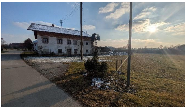
Abb. 17, Denkmalsgeschützter Bildstock (FI.Nr. 320/2) und zum Teil abgebrochenes Haus auf FI.Nr. 320, au- ßerhalb der Einbeziehungsfläche, Blickrichtung Süd- osten, LaN Feb. 2025
