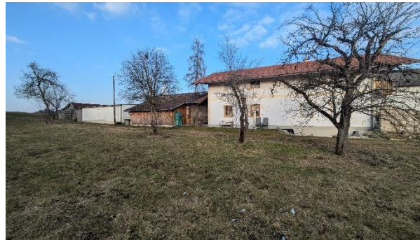
Abb. 11, zu entfernende Bäume im Osten der Einbeziehungsfläche. LaN Feb. 2025
