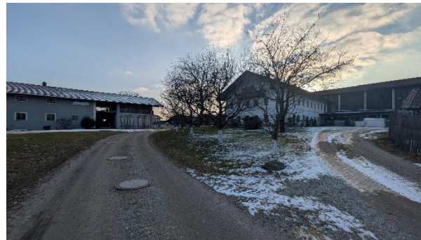
Abb. 5, Östliche Ortsteileinfahrt, Blickrichtung Süden, LaN Feb. 2025
