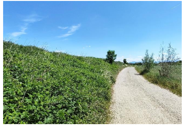
Abb. 14 Vegetation im Bereich des Erdwalls mit flächendeckenden Beständen der Großen Brennnessel, LaN, 28.05.26
