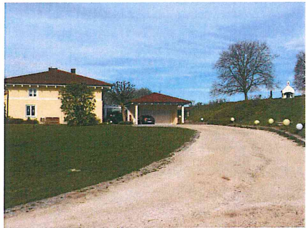
Zufahrt zu Haus Nr. 3b
